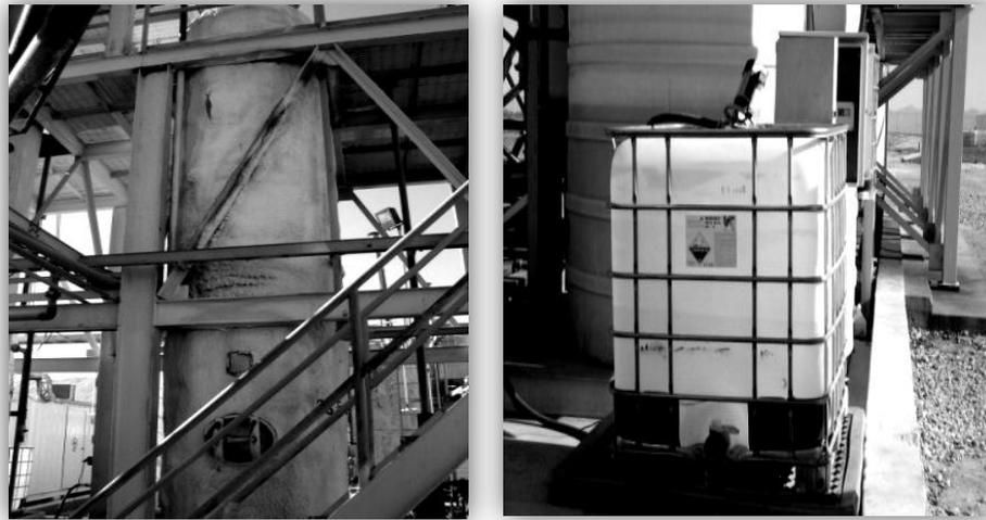
Figura 8. Tanque de despojo y depósito de almacenamiento de sosa
