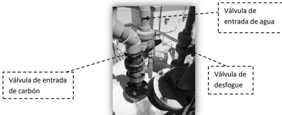
Figura 9. Parte superior del tanque de lavado ácido
