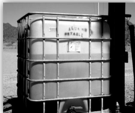
Figura 7. Tanque de preparación y depósito de almacenamiento de ácido clorhídrico
