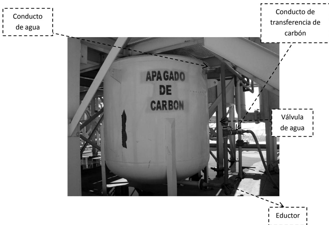
Figura 31. Tanque de apagado de carbón activado
