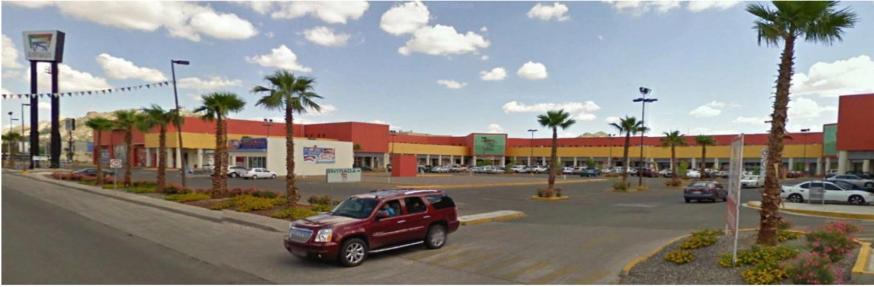
Figura 3.5 Vista exterior de Pabellón Reforma
