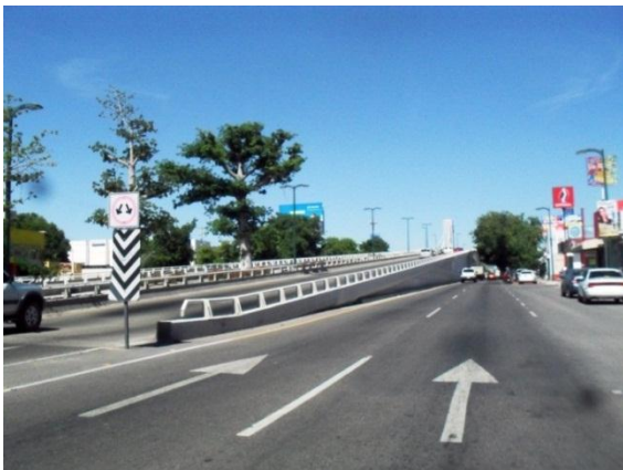
Figura 4.4 Distribuidor vial Morelos Fuente: Personal
