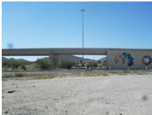
Figura 4.5 Distribuidor Altares Fuente: Personal
