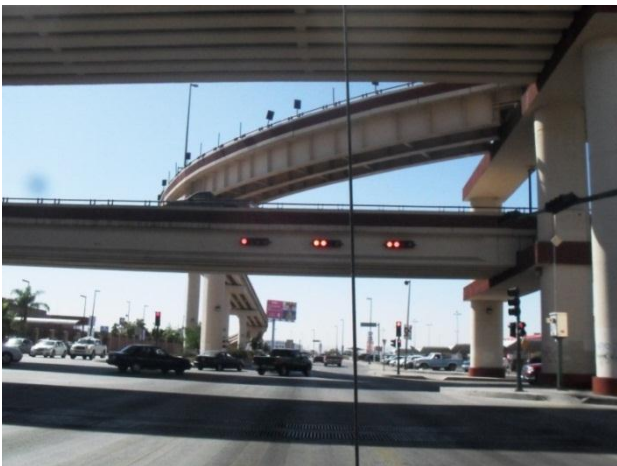
Figura 4.3 Distribuidor ubicado en Luis Encinas y Solidaridad. Fuente: Personal.
