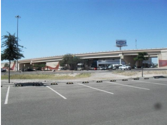
Fig 4.8 Distribuidor vial la Colorada. Fuente: Personal
