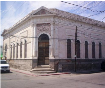
Figura 2.3 Vista de la sociedad de artesanos Hidalgo antes de su remodelación.
