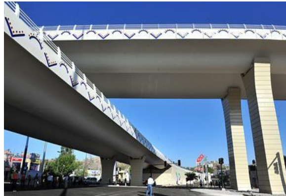
Fig. 4.11 Vista de Puente El Gallo Fuente: http://olasonora.com/graphics/11894/PUENTE+GALLO.jpg
