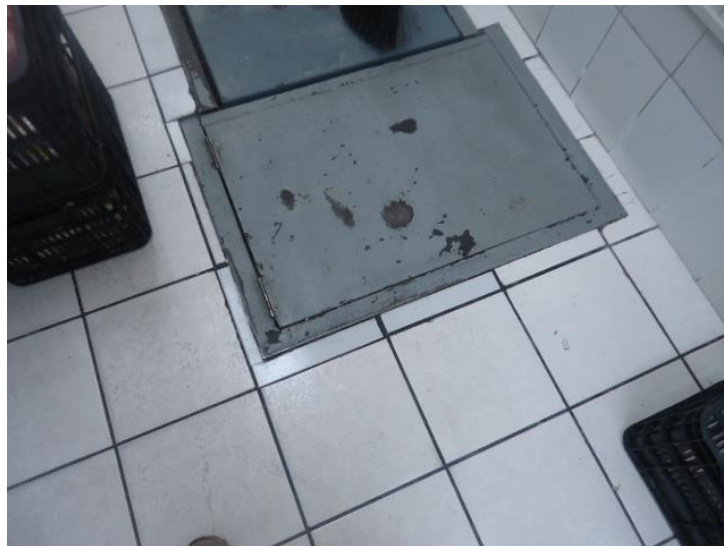
Figura 13: Reparación de Grieta de Anteprocreso.
