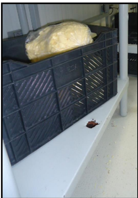
Figura 19: Daño Presentado por oxido en la Parte Inferior de la Mesa.
