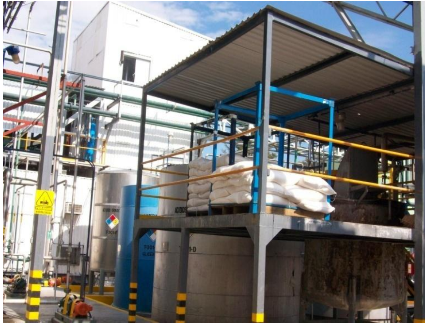
Figura 20. Área de tanque de fundición con el barandal de seguridad puesto
