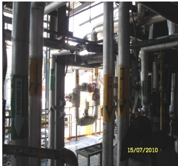
Figura 17. Tuberia con etiquetas de direccion de flujo
