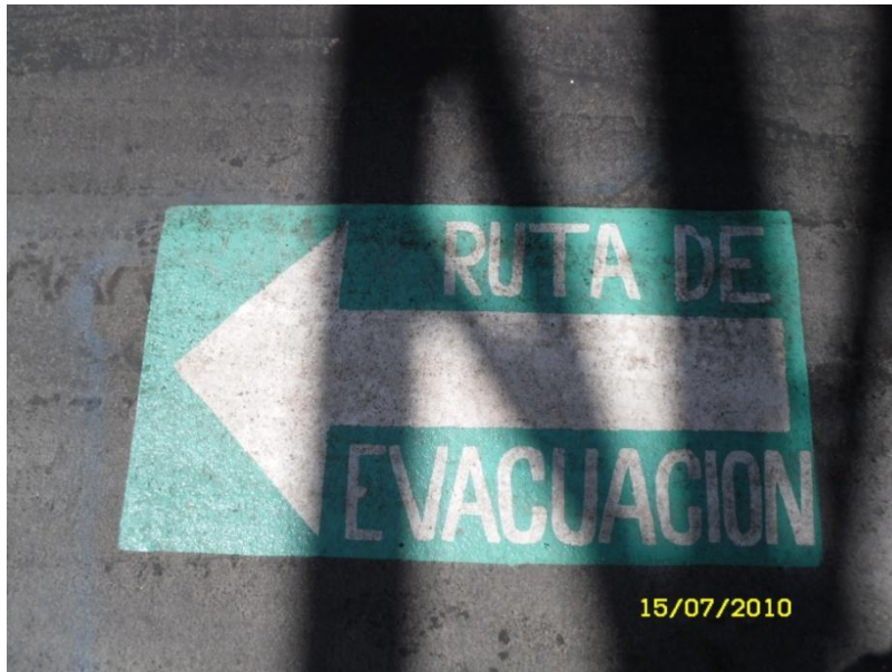
Figura 24. Señalamiento de ruta de evacuación
