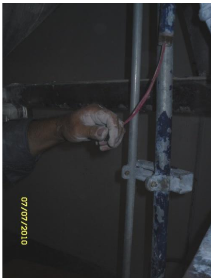
Figura 22. Tubo siendo reparado
