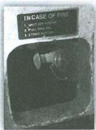
Figura 2A. Sistema de extinción de incendios.
