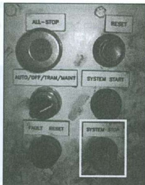
Figura 3. Ubicada en la caja de controladores de la máquina.
