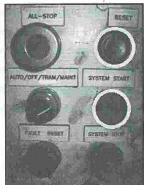
Figura 8B. Caja de controladores.
