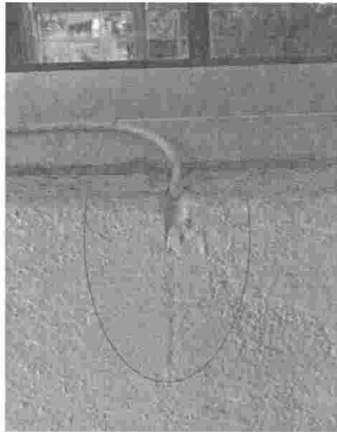
Figura 1.2. Cableado del lector de tarjetas hacia el controlador aula 5G-201
