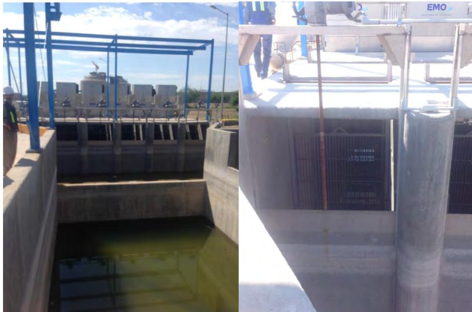
Figura 2A. Canal Parshall y Rejillas
