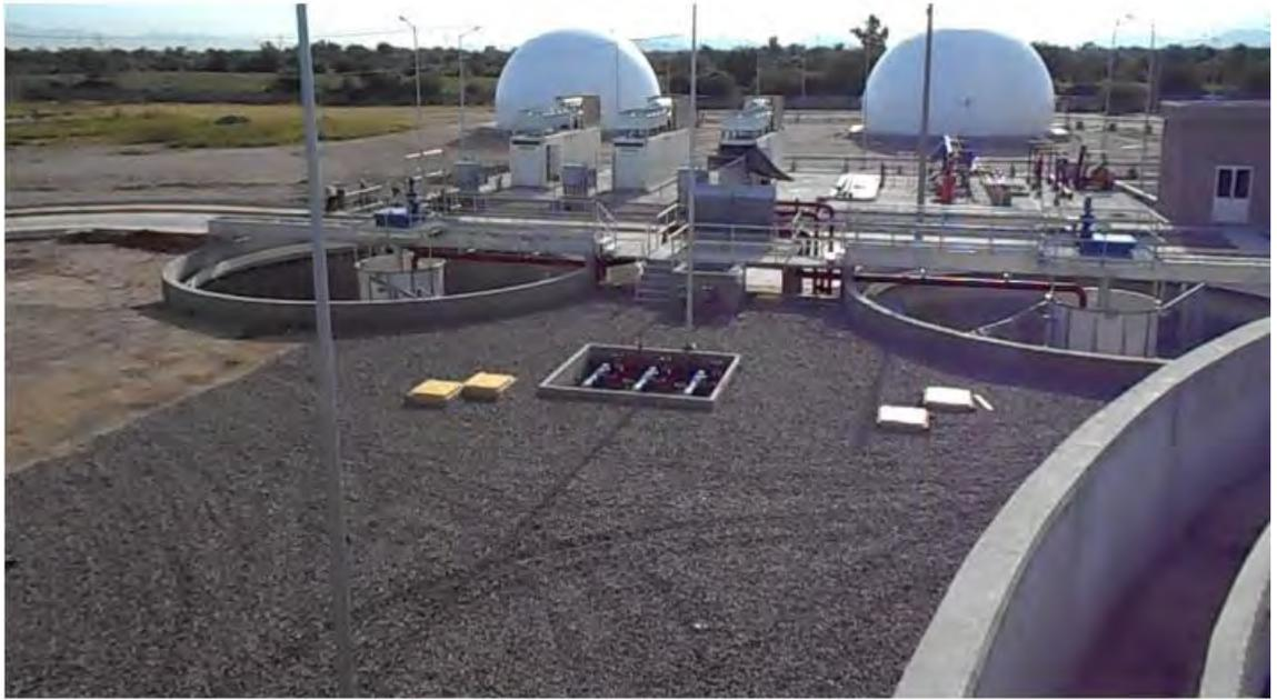
**Figura 9A. Tamiz y Espesadores Gravimétricos**
