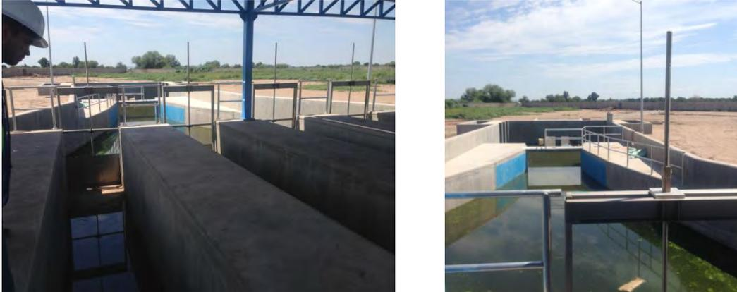
**Figura 13A. Desinfección: Rayos Ultravioleta y Canal Parshall**
