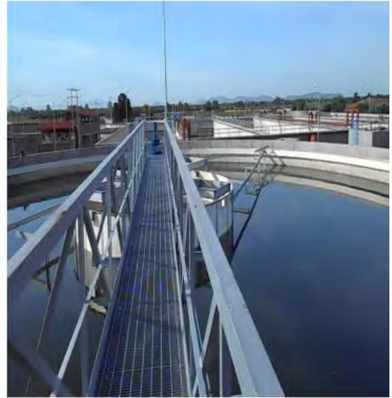
**Figura 6A. Sedimentadores Primarios**
