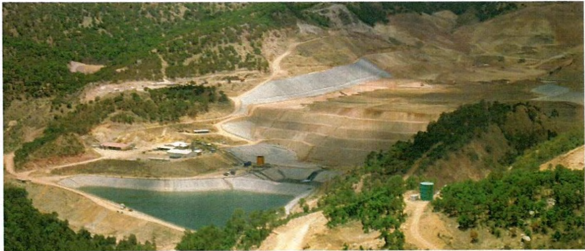
Figura 5. c. Patios de Lixiviación y piletas
