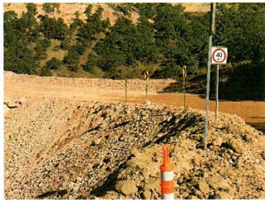
Figura 4.f. Ampliación de caminos (Tiradero de piedras en Filtro)
