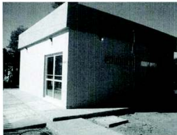
"Fachada de Sala Audiovisual"
