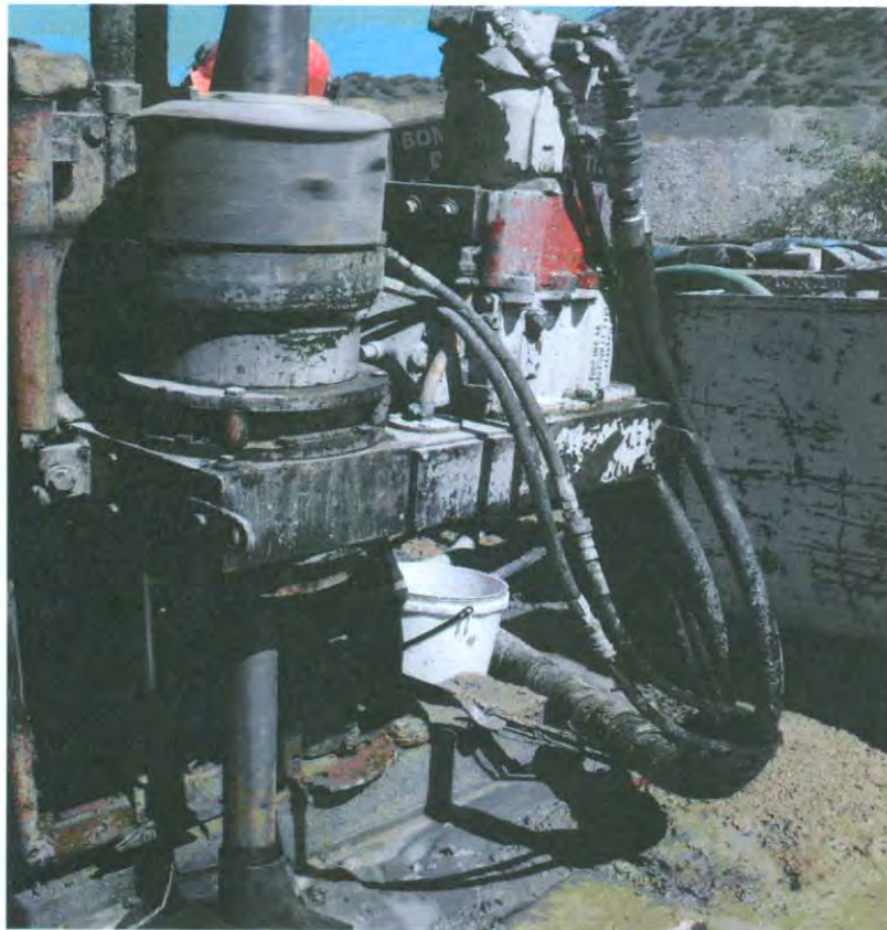
Figura 7. Máquina perforadora de anillo de la empresa GeoDrill.
