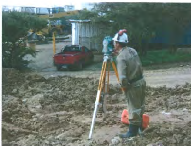
Figura 5. Nivelación de estación
