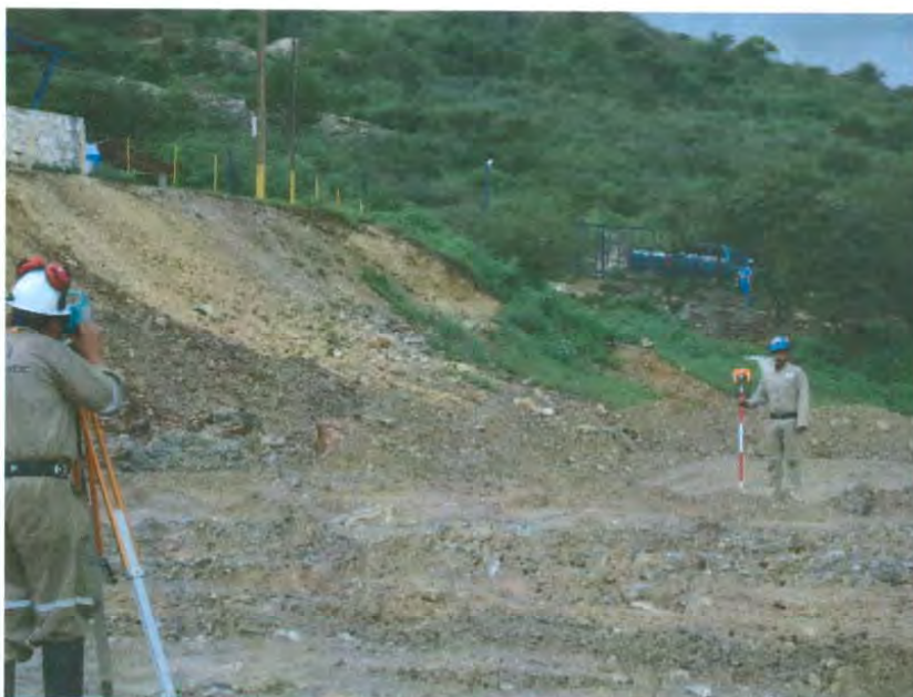
Figura 6. Levantamiento topográfico
