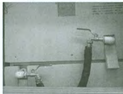
Figura 6.5 Válvulas de paso, suministro de agua de las placas frías.
