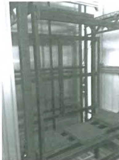
Figura 5.35 Contra pesos para evitar la inclinación hacia enfrente de la palca caliente
