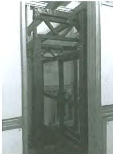
Figura 5.33 Estructura móvil en la que se aprecia la armadura para evitar el pandeo
