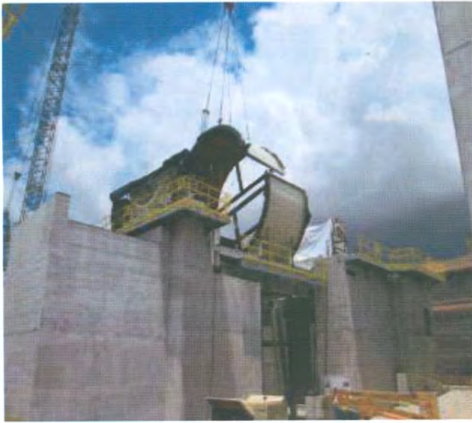
Figura 25. Montaje de Sección #2.
