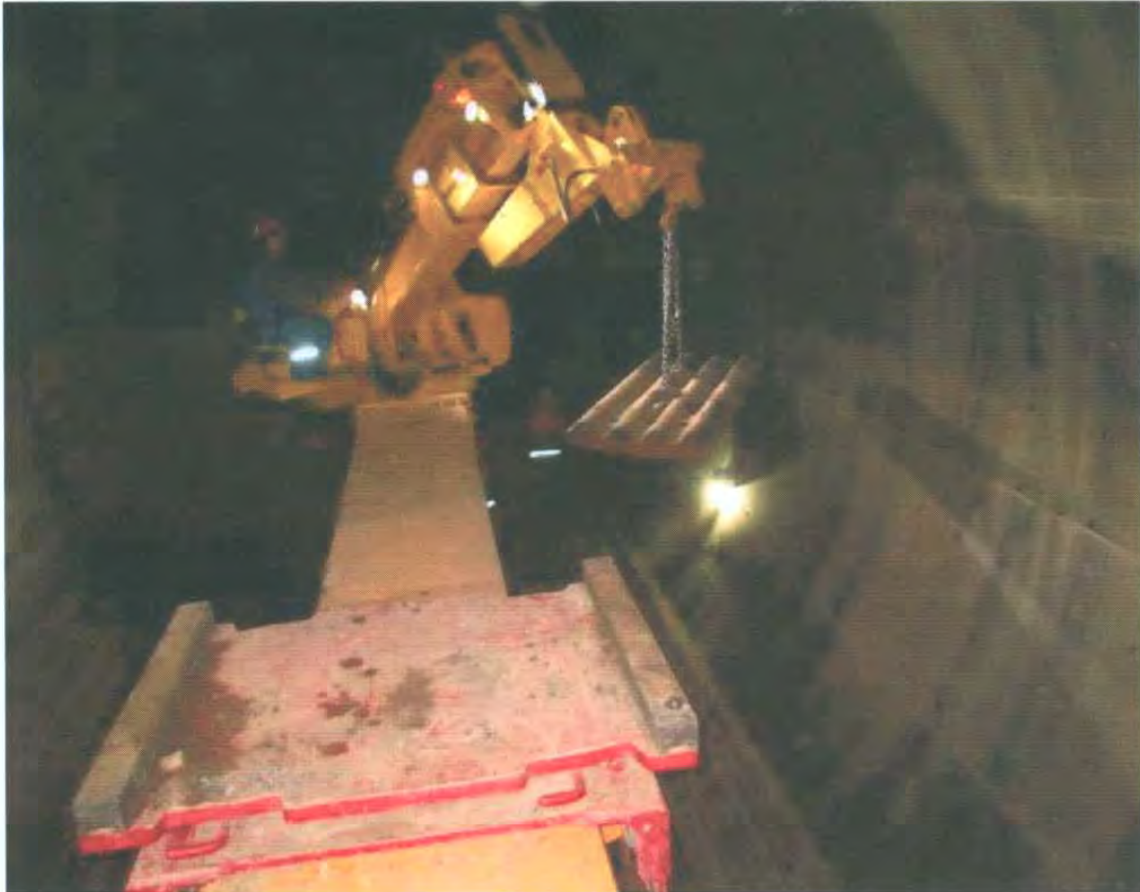
Figura 38. Colocación de laines para proteger al molino.
