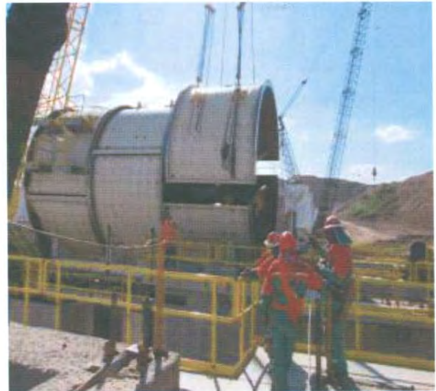
Figura 28. Montaje de sección #6.
