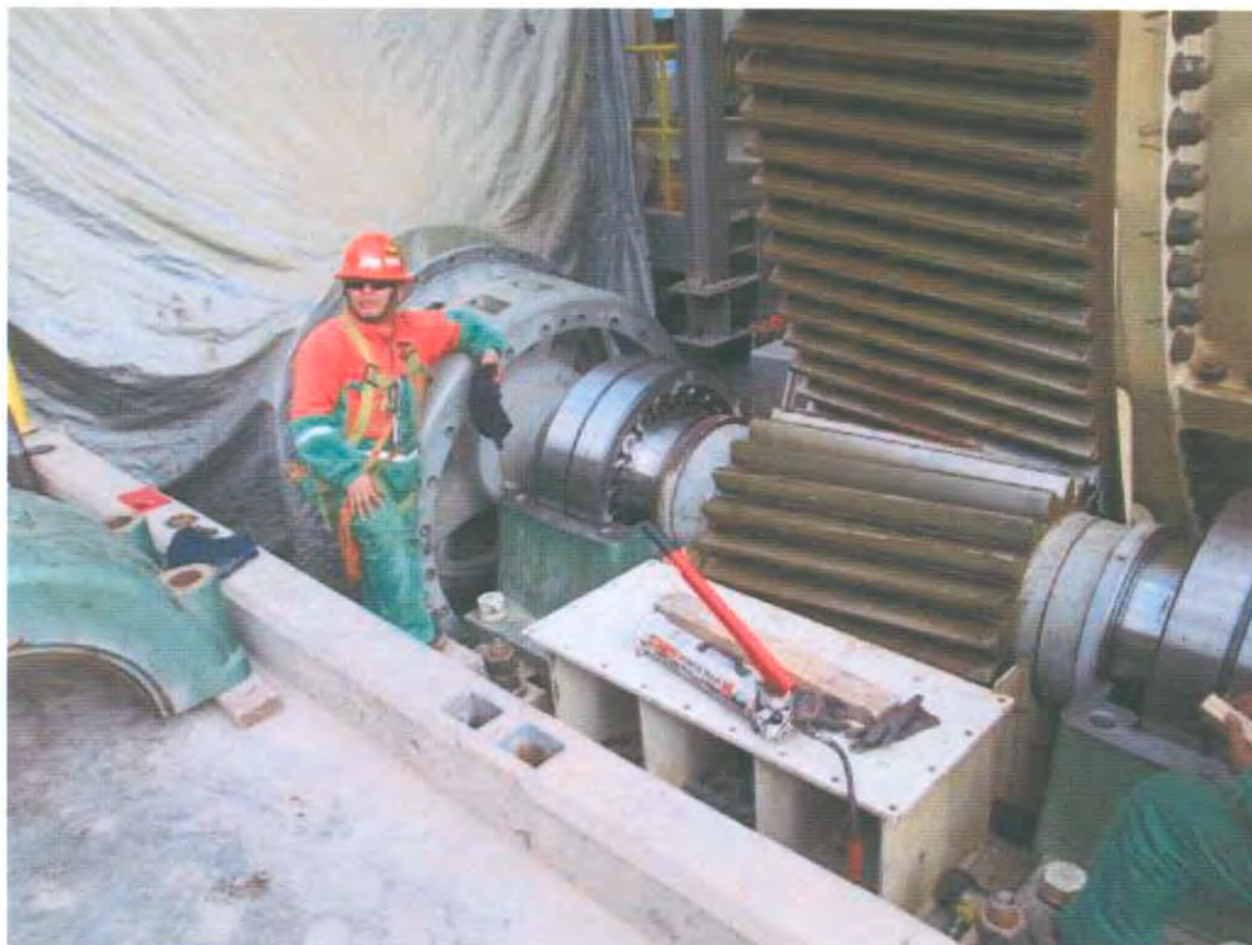
Figura 35. Prueba de ensamble entre el piñón y corona.
