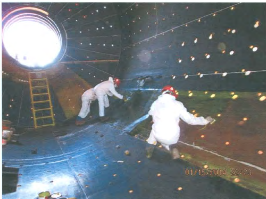
Figura 37. Aplicación de caucho para el revestimiento del molino.
