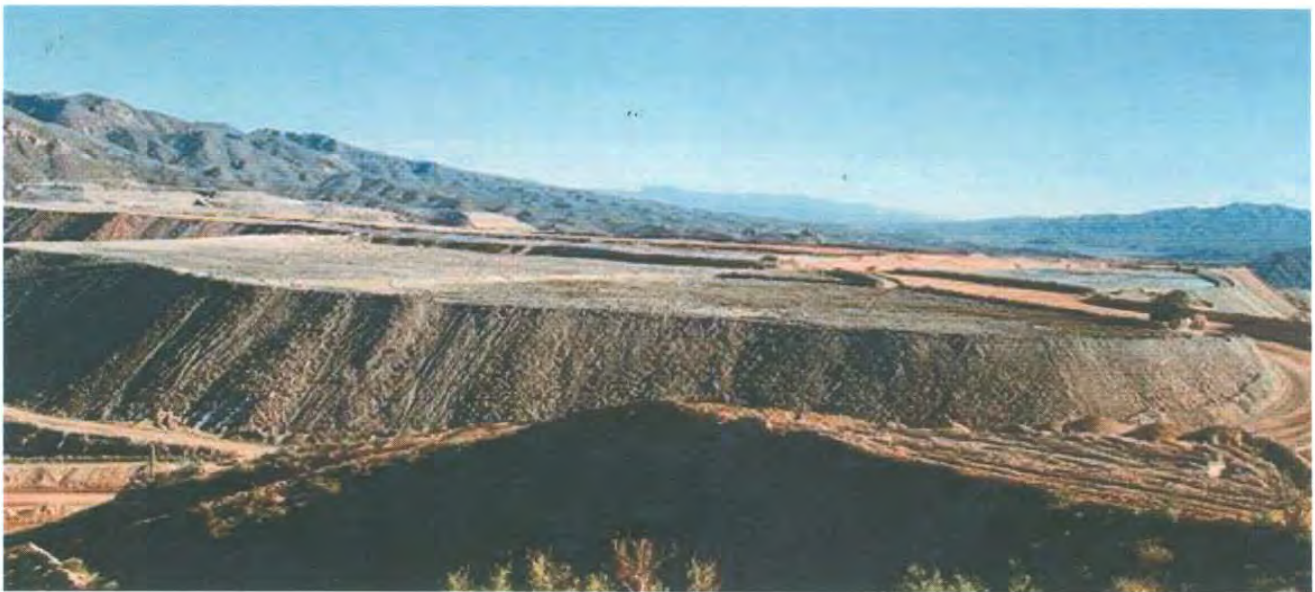
Figura 15. Patios de lixiviación en Buena Vista.
