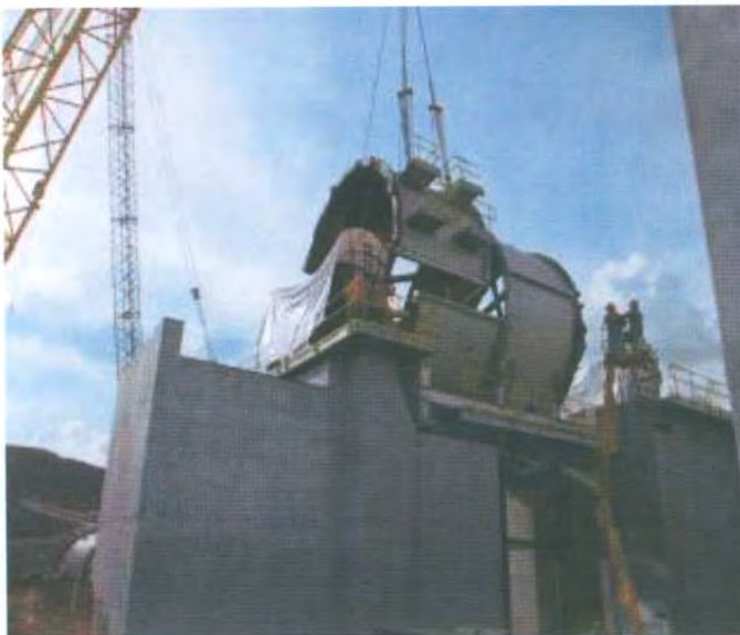
Figura 27. Montaje de sección #4.
