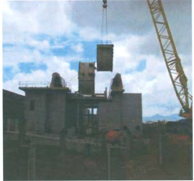
Figura 26. Montaje de sección #3.
