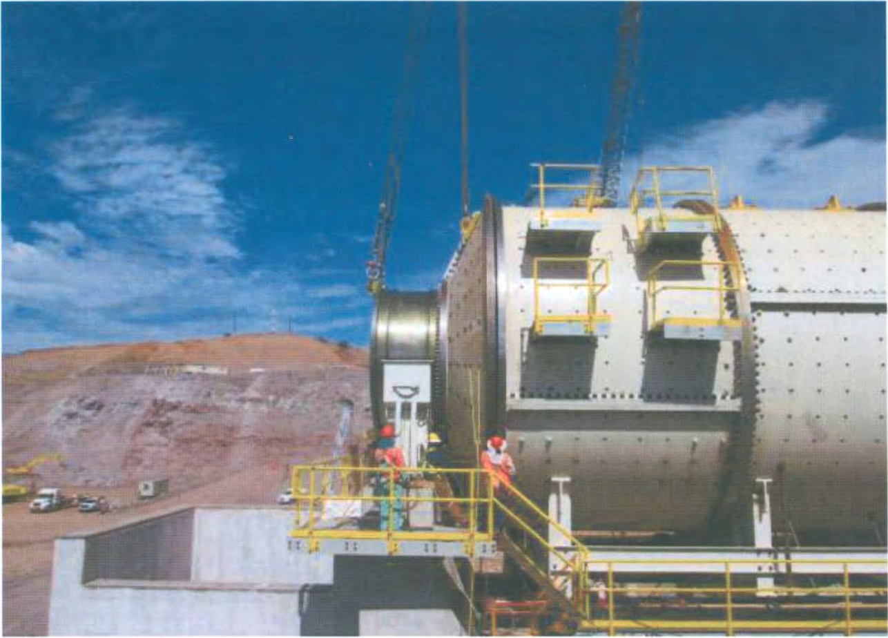
Figura 33. Ensamble de cabezal-muñón con el cilindro.
