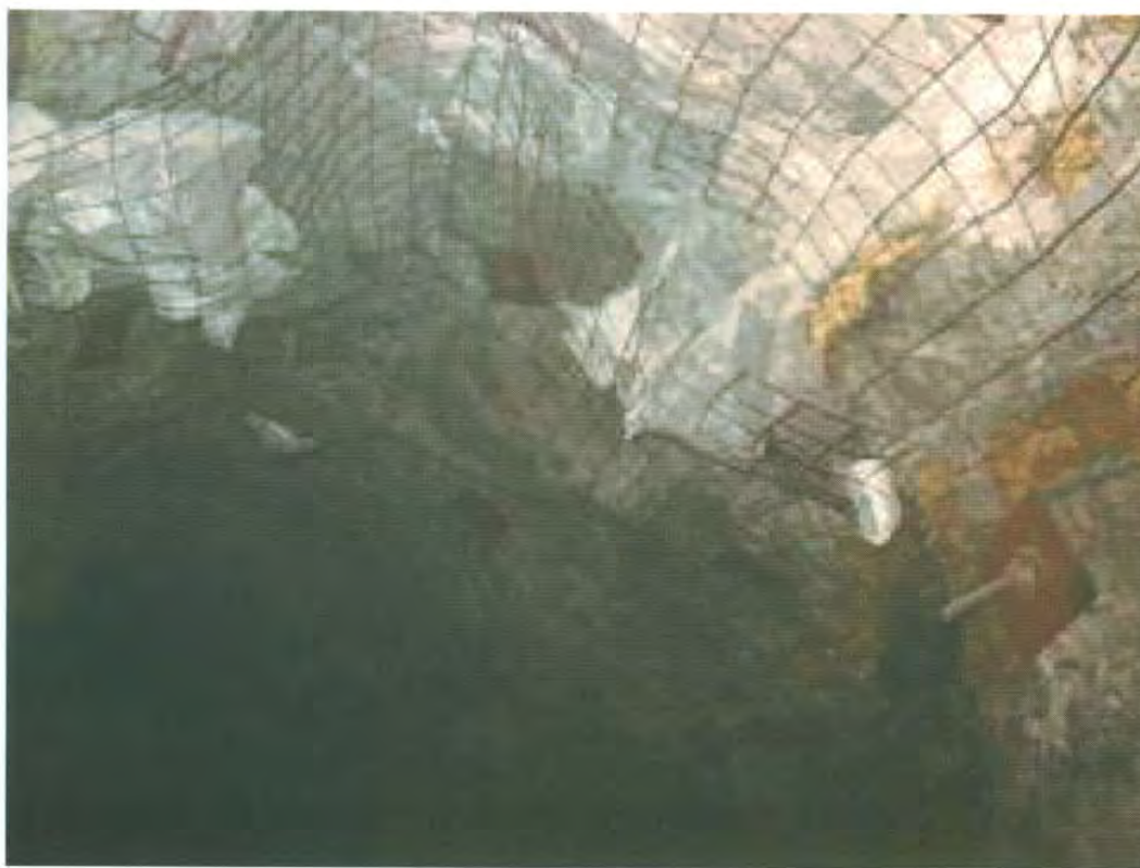
Figura 12. Pernos de anclaje con malla.
