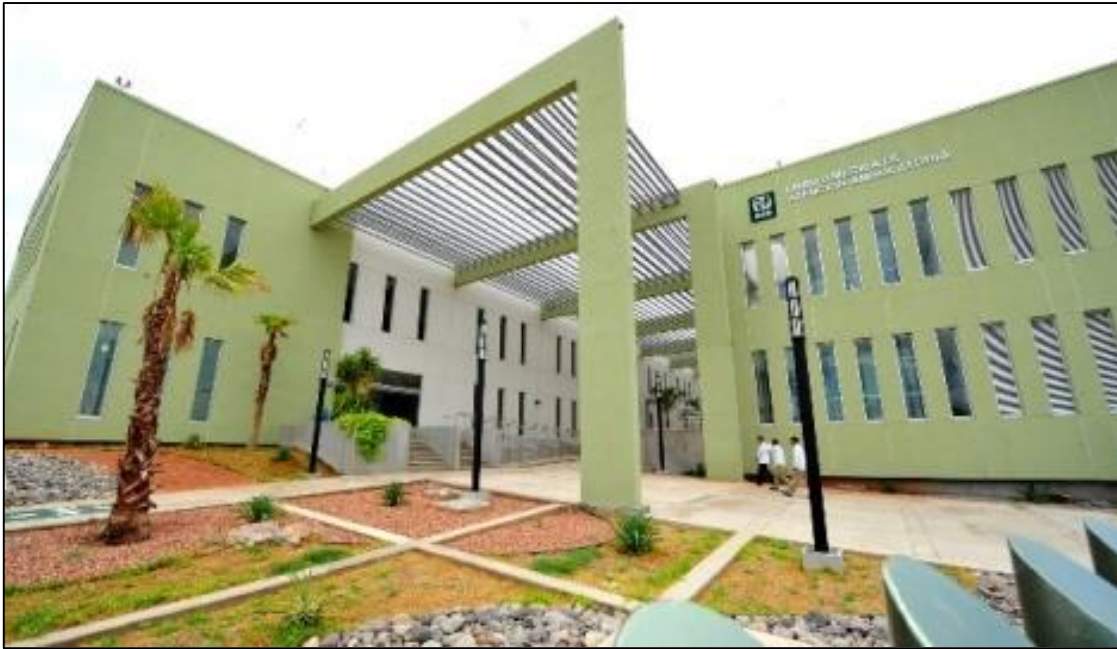
Ilustración 467. Vista desde la plaza de acceso hacia la edificación. Fuente: Google Imágenes.
