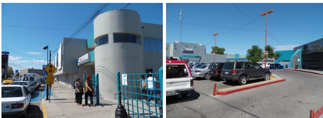
Ilustración 13. Vistas exteriores de la edificación. Fuente: Fotografía del autor.
