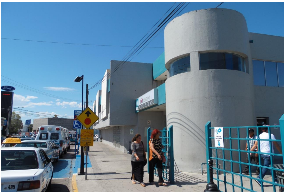
Ilustración 11. Acceso al área de urgencias sobre la calle Benito Juárez. Fuente: Fotografía del Autor.
