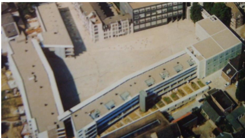
Imagen 2. Viviendas en el centro histórico de Maastricht, Holanda. Vista aérea. Fuente: Wikipedia.
