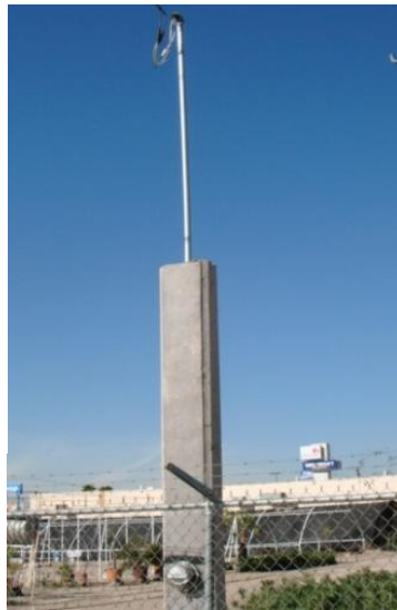
Imagen 34. Medidor. A una altura de 1.60 sobre el nivel del terreno se encuentra ubicado el medidor sobre la avenida trece. Fuente: ALJC.
