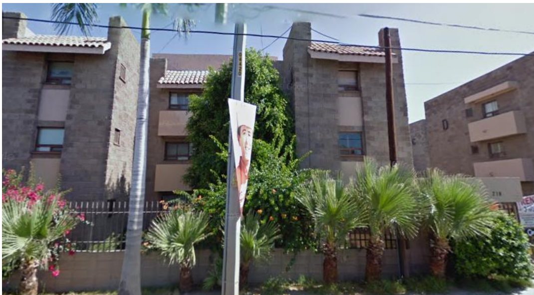
Imagen 12. Residencial sobre el Blvd. Ignacio Soto y la calle mesa 3 ríos. Fuente: ALJC.
