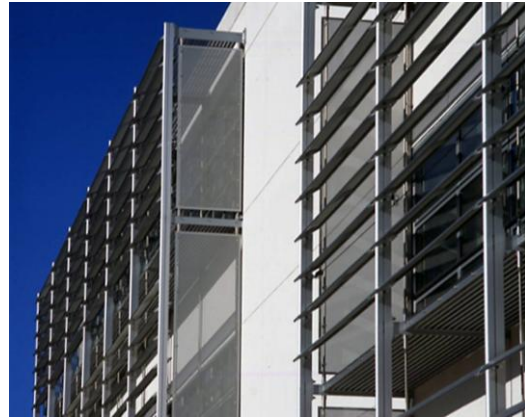
Imagen 50. Celosías móviles. Fuente: High tech Co.
