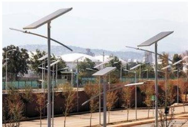
Imagen 72. Luminarias exteriores. Fuente: Google images.
