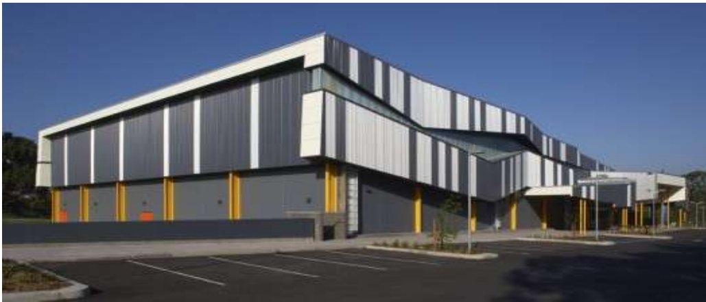
Fotografía 8. Detalle de la fachada principal
