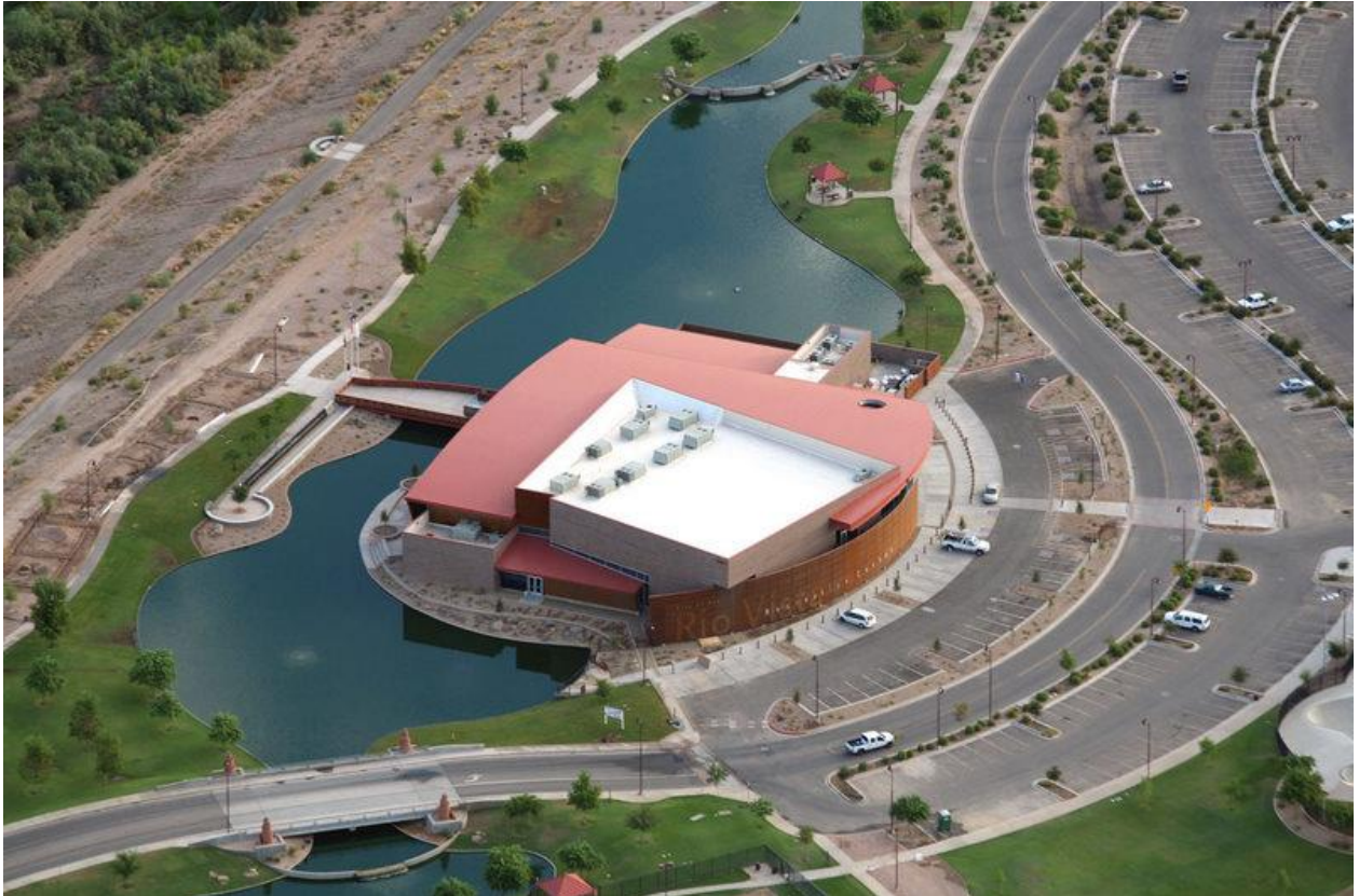
Imagen 21. Edificios de Usos Múltiples.
