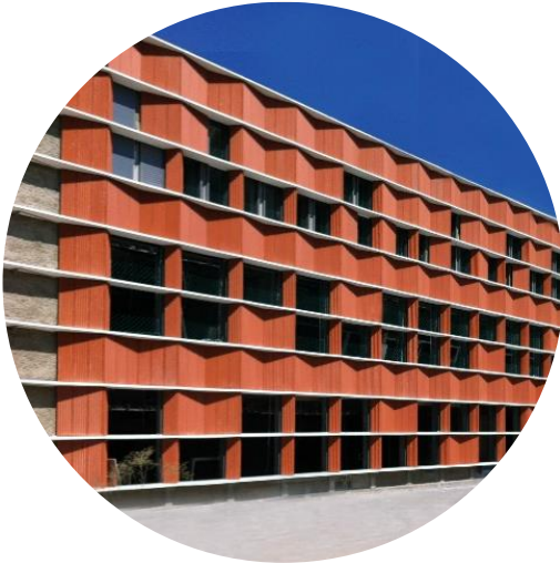
Imagen 2.3: Celosía para sombra. Fuente: www.archdaily.com
