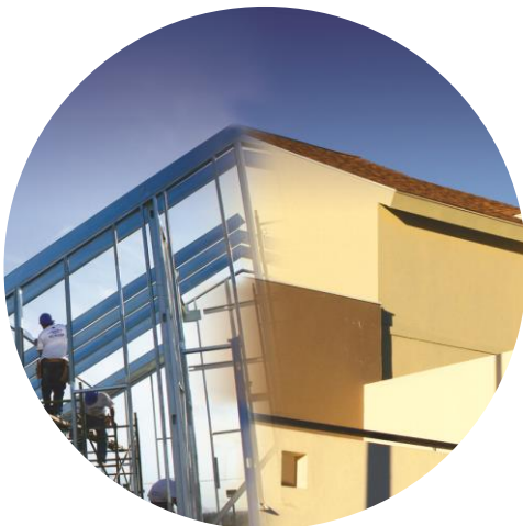
Imagen 2.13: Subestructura de perfiles galvanizados.
