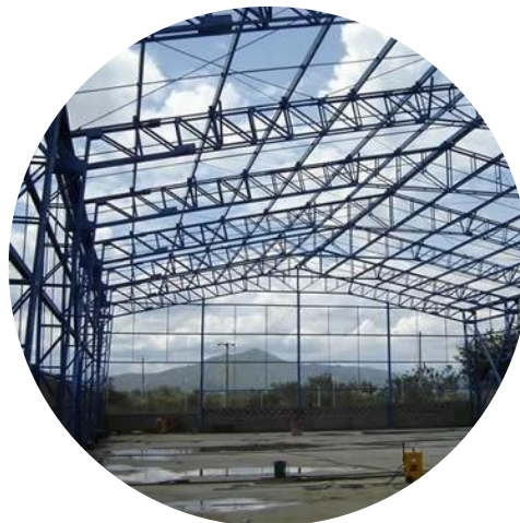
Imagen 2.13: Subestructura de perfiles galvanizados.
