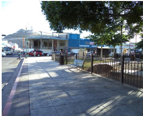
Fotografía 2.6.- Vista norte de fachada del edificio Escalante. Fuente: Autoría propia.
