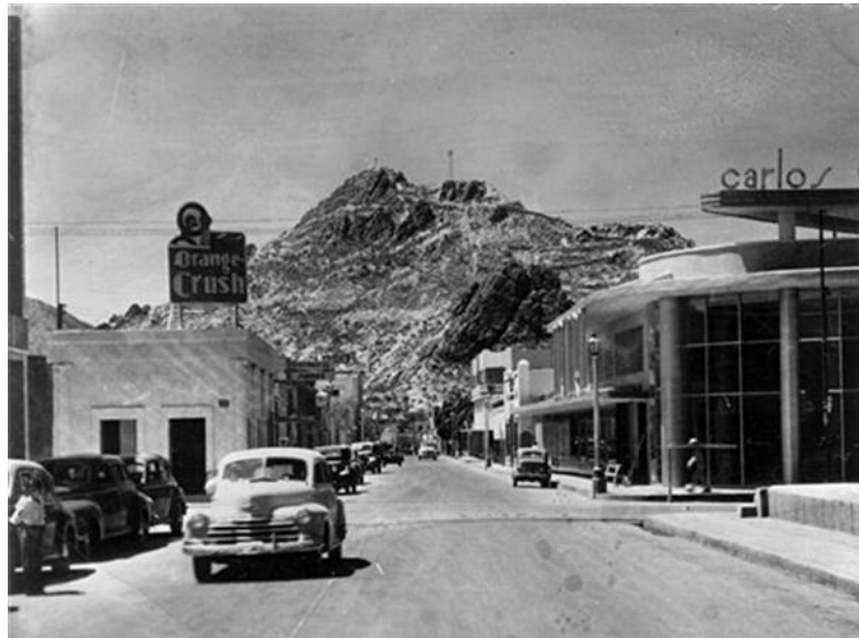
Fotografía 1.7.- Edificio Carlos V. Escalante.
