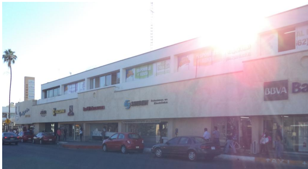
Fotografía 2.14.- Edificio de tres niveles. Fuente: Autoría propia.
