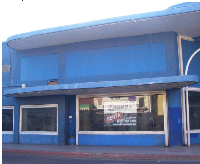
Fotografía 2.23.- Recubrimiento cerámico de la fachada este. Fuente: Autoría propia.
