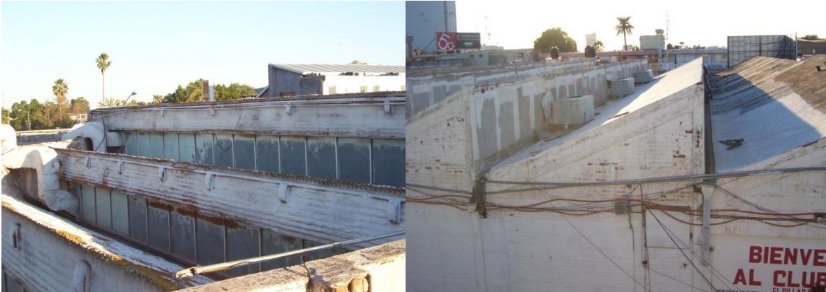
Fotografía 2.7.- Sistema de diente de sierra en edificio Escalante y en construcción aledaña. Fuente: Autoría propia.
