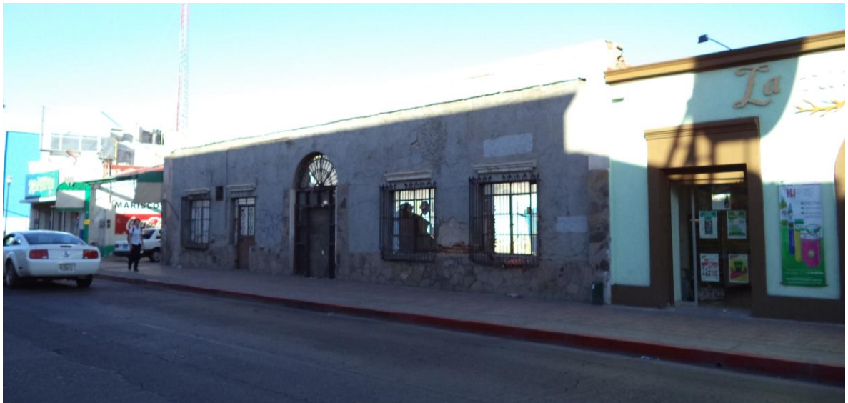
Fotografía 2.8.- Fachadas sobre la calle Juárez (opuestas al edificio Escalante). Fuente: Autoría propia.
