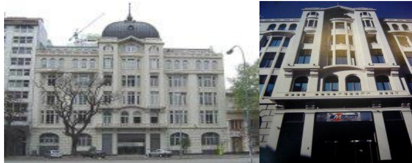
Fotografía 1.5.- Fachada Principal. Fuente: Artículos de reciclaje de la Revista HABITAT.
