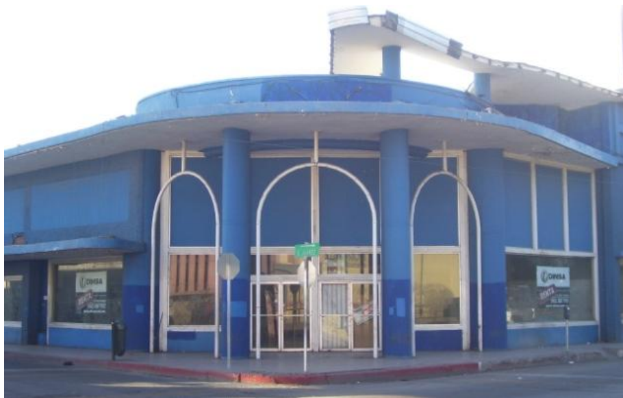
Fotografía 2.21.- Fachada noreste del edificio Escalante. Fuente: Autoría propia.
