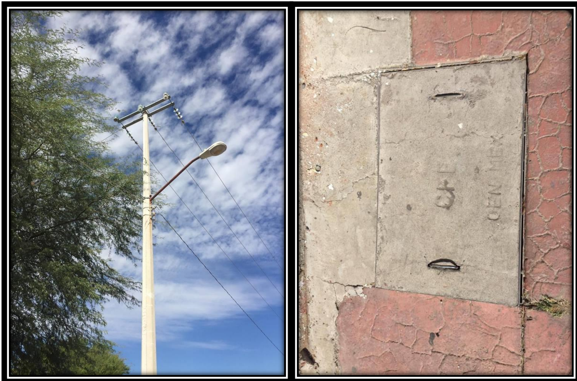
Imagen II. 1 Red eléctrica aérea (izquierda). Fuente propia.
