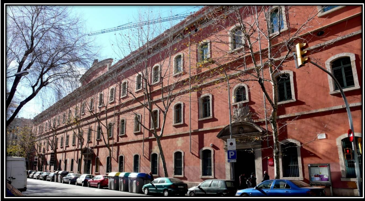
Imagen 1. 16 Fachada principal del edificio en donde se encuentra el museo. Fuente: http://bcnenfotos.blogspot.mx/2013/02/el-barrio-de-santa-catalina-y-san.html
