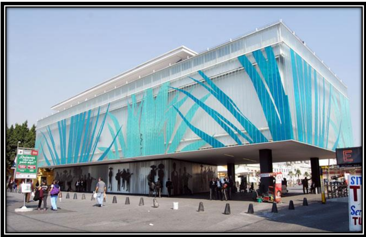
Imagen I. 5 Composición del edificio sobre planta libre. Fuente: http://www.ciudadmexico.com.mx/atractivos/museo_tequila.htm
