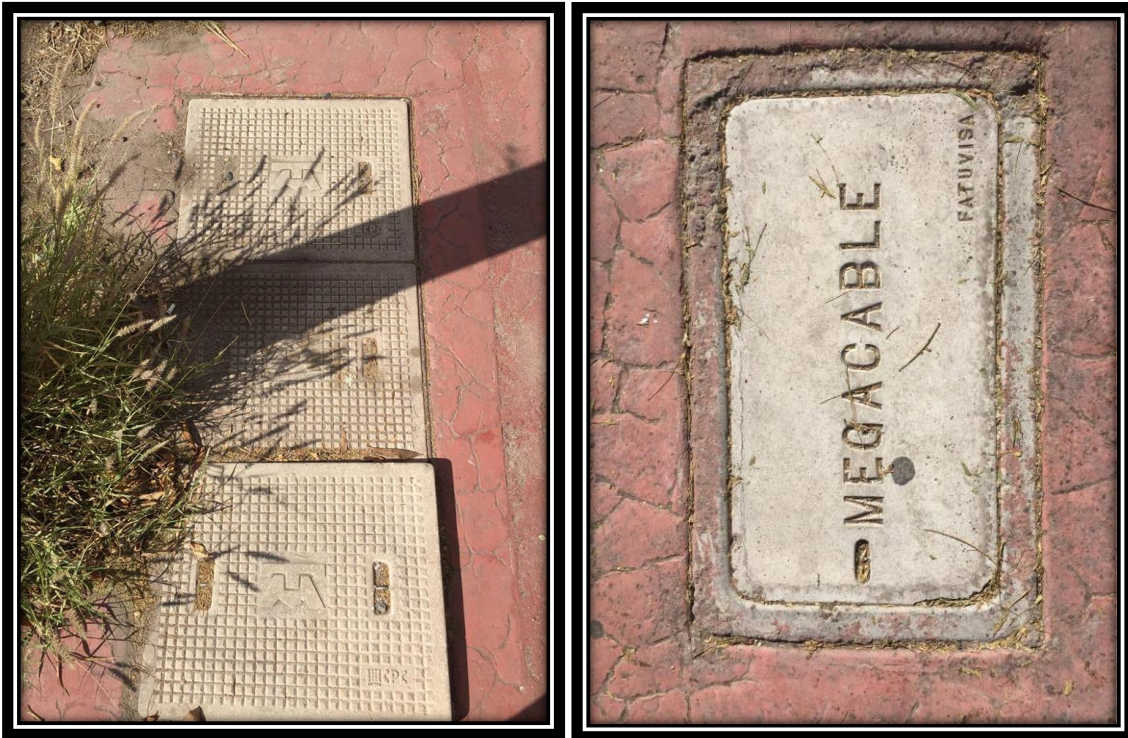
Imagen II. 6 Registros de teléfono (izquierda). Fuente propia.
