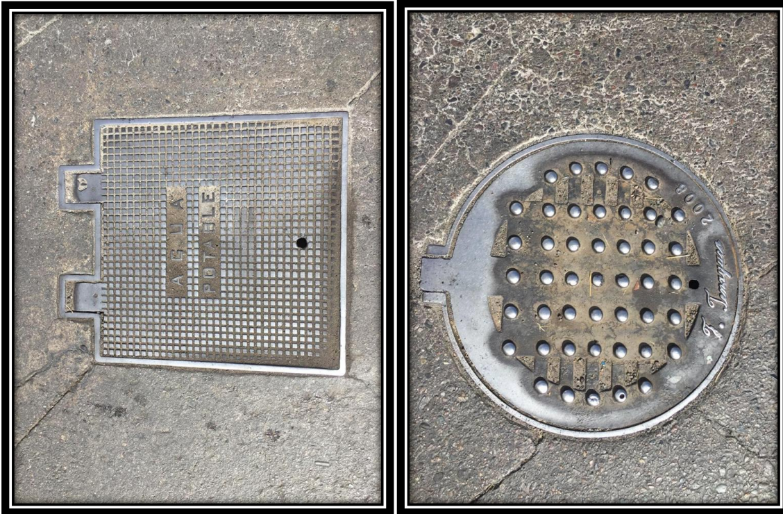
Imagen II. 4 Registros de agua potable (izquierda). Fuente propia.
