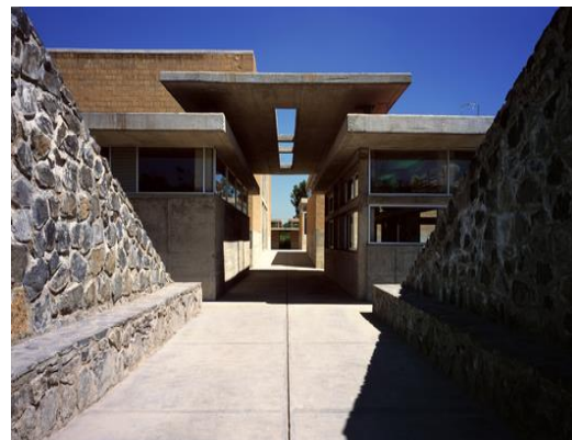
Fotografía 1.6. Pasillos exteriores Fuente: (ArchDaily2)
