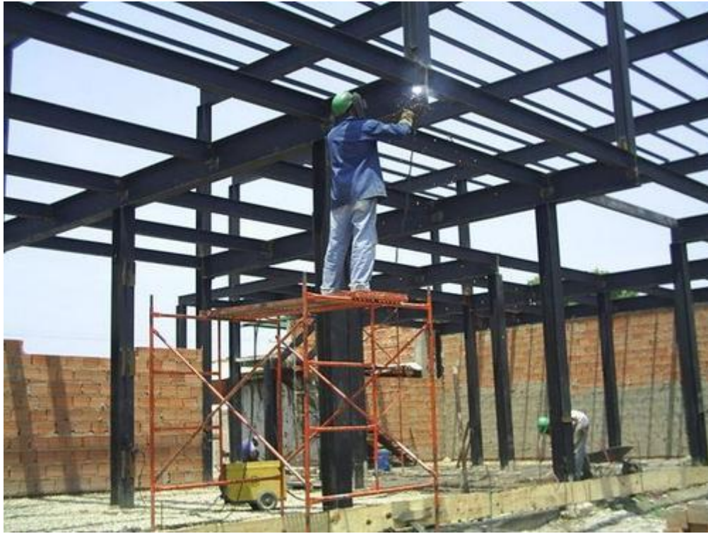
Imagen 65. Sistema estructural metálico.
