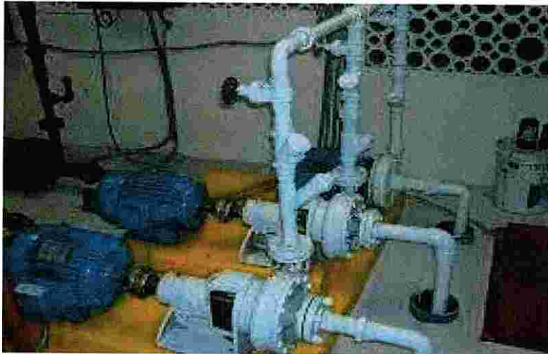
Figura 6.- Bombas de agua
