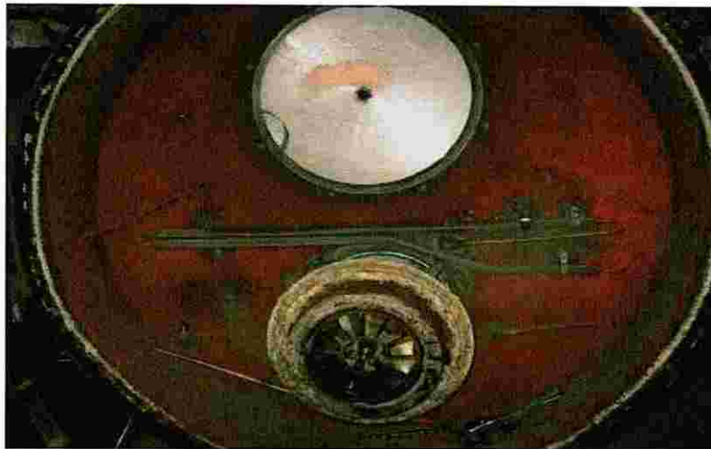
Figura 4.- Quemador de la caldera
