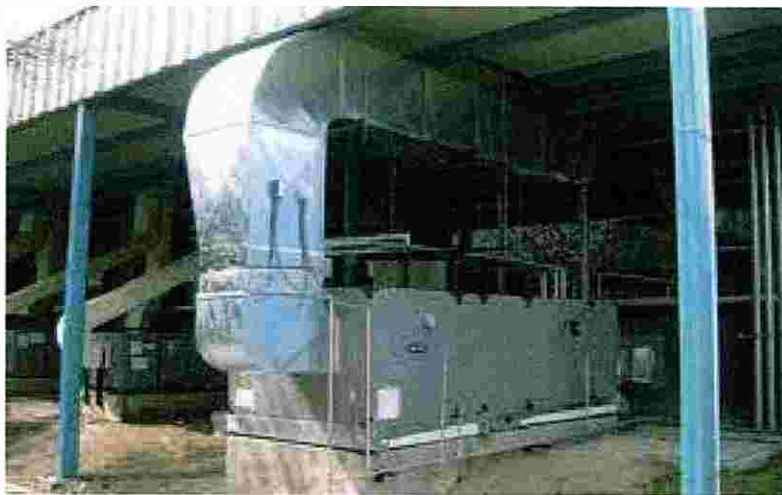
Figura 9.- Unidad manejadora de aire (UMA)
