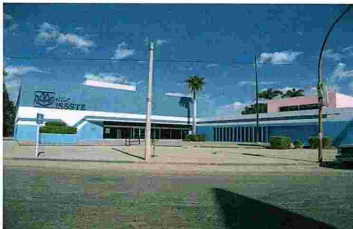
Figura 2. Clínica hospital del ISSSTE
