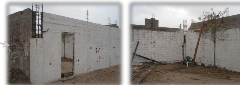
Imagen 1.10. Construcción 2. A la izquierda, vista exterior de la construcción. A la derecha (vista interior) Fuente propia.
