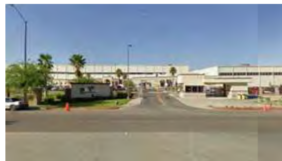
Imagen 28: Acceso Planta Magna (Fuente: Google Earth)
