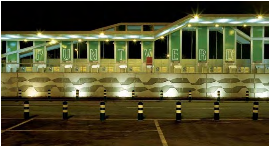
Ilustración 12: Fachada principal de Punt Verd. La iluminación abarca el conjunto completo creando ambientes agradables. (Fuente: http://www.archdaily.mx ).
