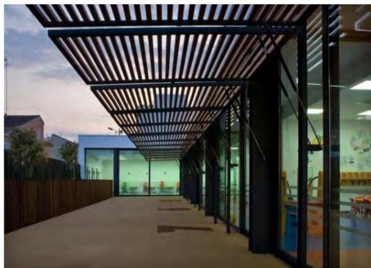
Imagen 10. Protección de solar con mallorquinas elevables. Fuente: (Paralex, 2015), edición propia.
