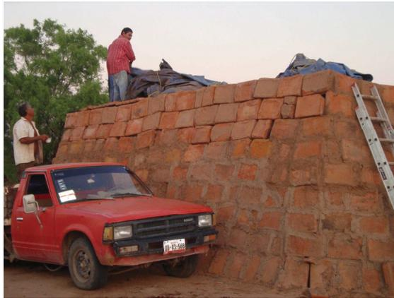
**Figura 5.** Enjarre del horno ladrillero con adobe y lodo.
