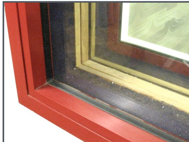
Imagen 29 y 30 . Sección y detalle de ventana a prueba de sonido.
