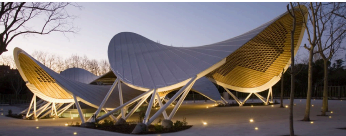
Imagen 2.- Estructura de madera para la cubierta de un auditorio al aire libre en el parque El Paraíso, San Blas, Madrid. Fuente: acanaglulam.com
