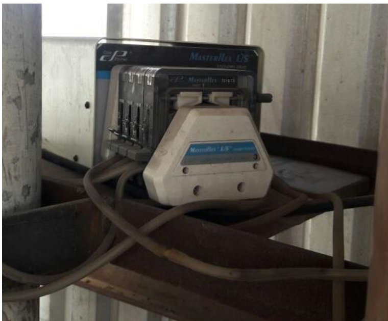
Figura 10. Bomba utilizada para la dosificación de cianuro.
