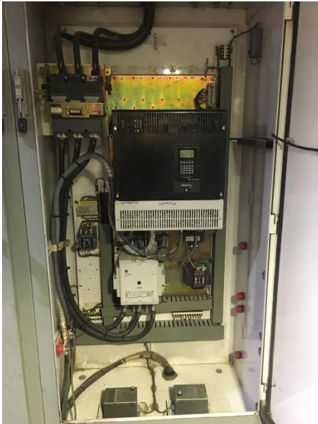
Figura 69. El drive marca Allen Bradley adaptado e instalado (controlador motor de levante).
