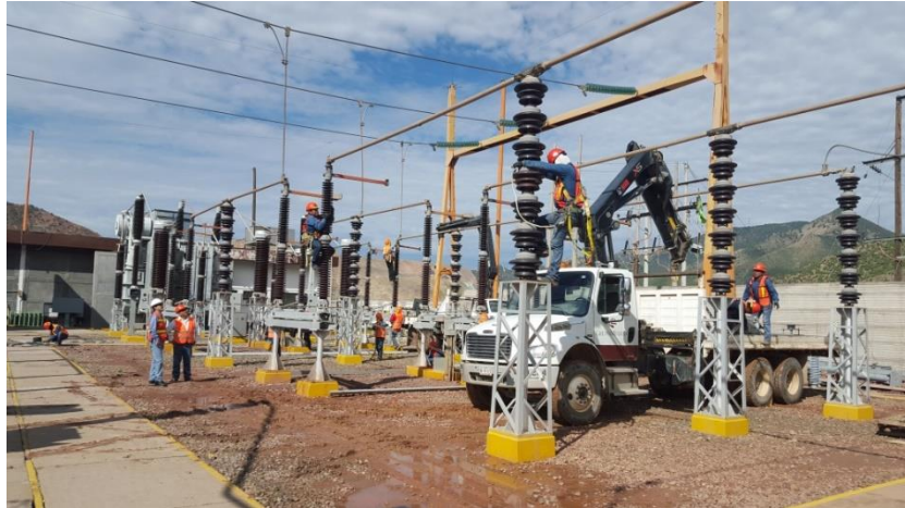
Figura 63. Desmantelamiento y sustitución de cuchillas y aisladores.
