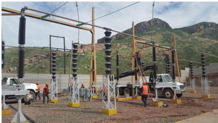
Figura 64. Adaptando el nuevo equipo en las líneas de transmisión de las cuchillas.
