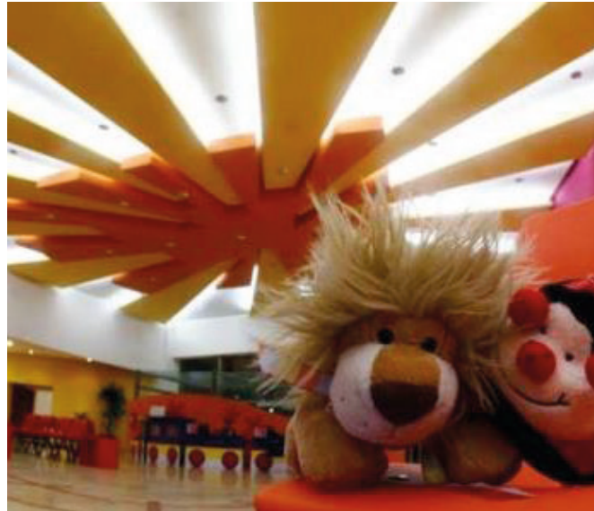
Ilustración 07. Detalle de la plafonería en el vestíbulo. El diseño de plafones está ejecutado en tablarrocas que generan una estrella que simula a Sol con su radiación. El edificio está “vivo” y lleno de color desde el momento en que se accede a él. Imagen recuperada del Imparcial en línea.
