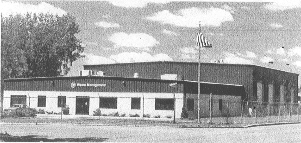
Fig. 2.13 Edificios industriales con muros de panel de acero laminado en frío; (a) Edificio con muros casi completos a base de panel de lámina; (b) Edificio con muros fabricados parcialmente con panel de lámina.
