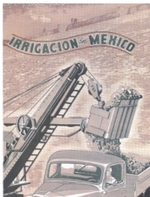
Figura 14. Maquinaria en la Presa El Girón, Hidalgo, 1939. Tomado de Irrigación en México , vol. 19, no.3 (portada).
