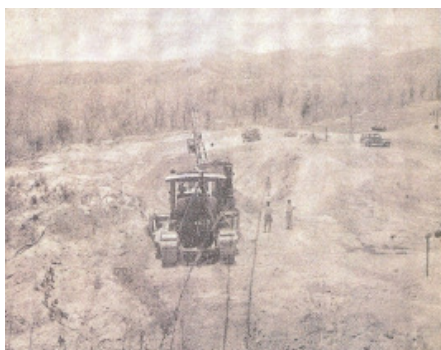
Figura 7. Trabajos en la presa de Sanalona, Sinaloa, 1942.
