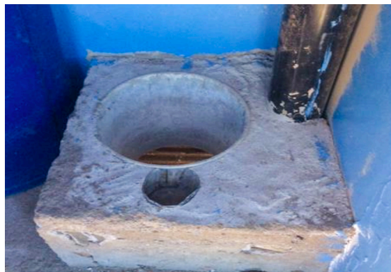
Figura 7. SES construido en la escuela primaria de la comunidad. Fuente: Elaboración propia.
