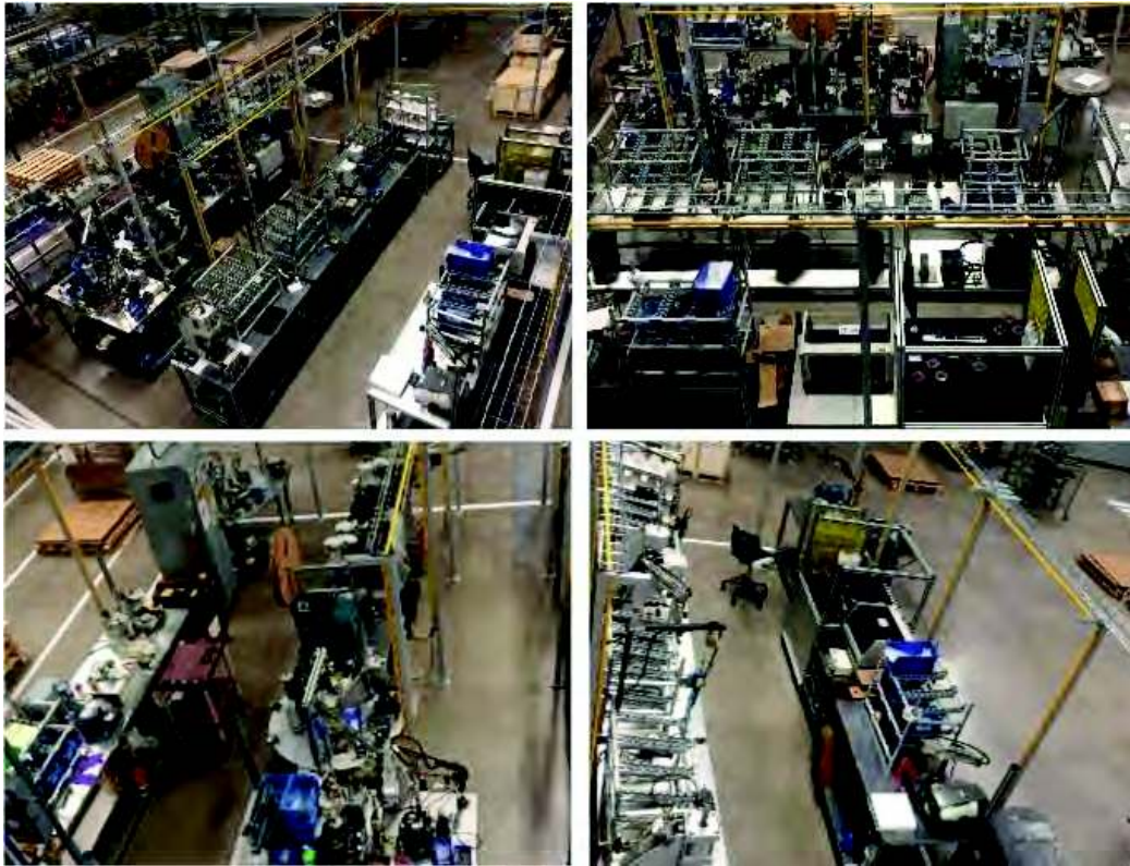
Figura 4.13 Instalación de nuevo diseño de línea.
