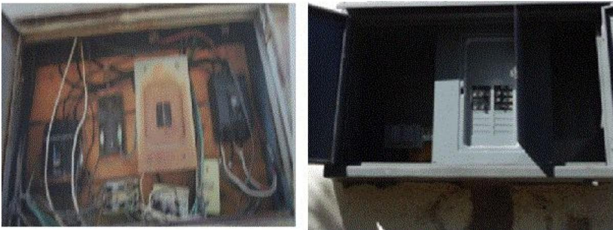
*Figura 4.24. Antes y después del mantenimiento de centros de carga.*
