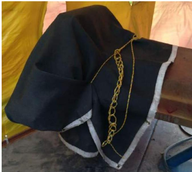
**Figura 4.22** Ejemplo de utilización de manta para enfriamiento lento
