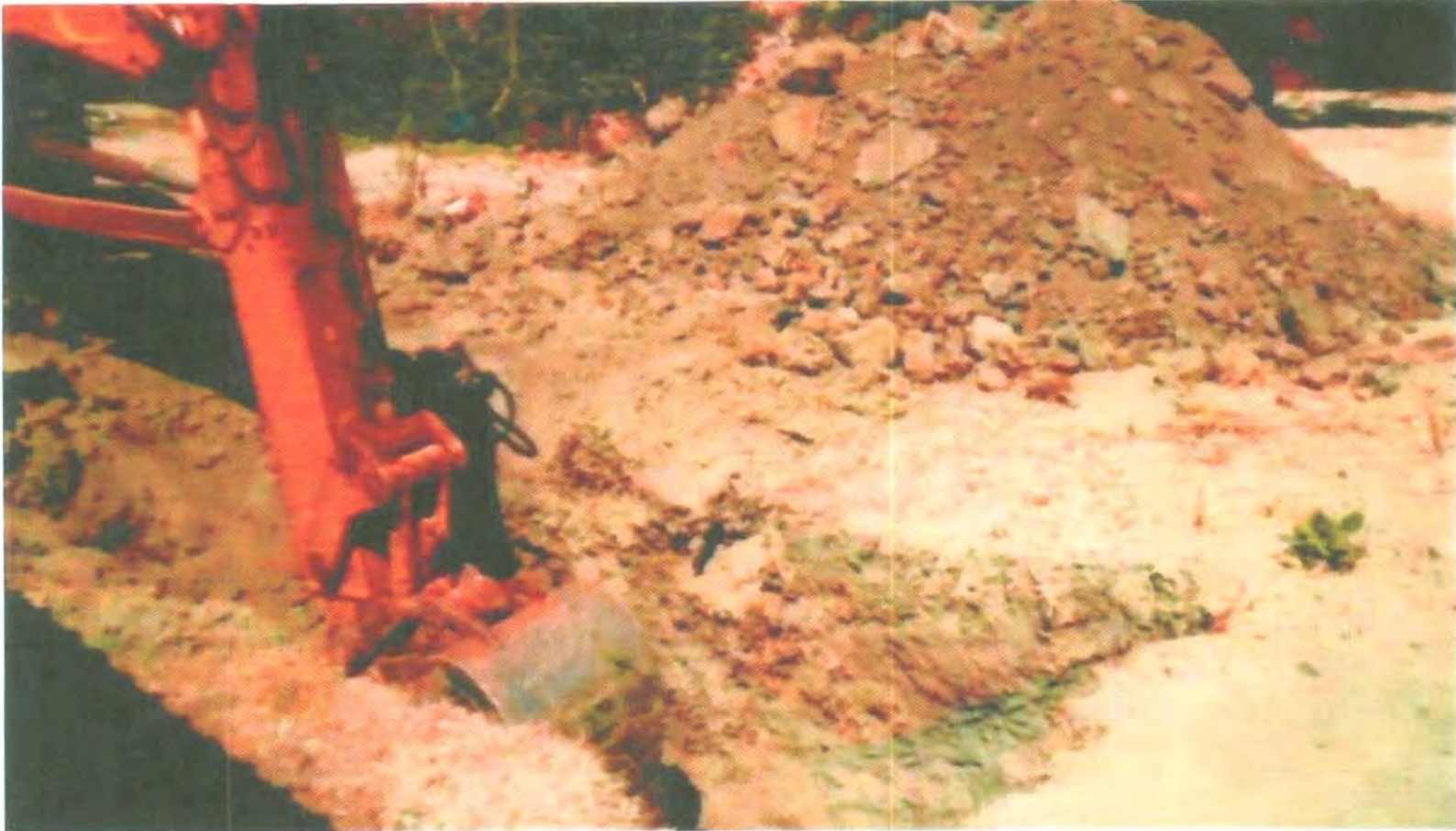
Figura 6. Pozo a cielo abierto (Civilbeta, 2020)
