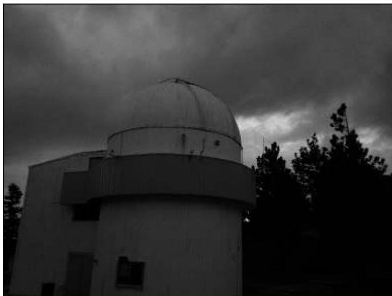
Figura 3.7. Edificio de telescopio de 0.84 m del OAN SPM por su exterior. Con una altura de \sim 10 metros y cuenta con tres pisos. Fotografía: Carlo Alí Medina Leal.
