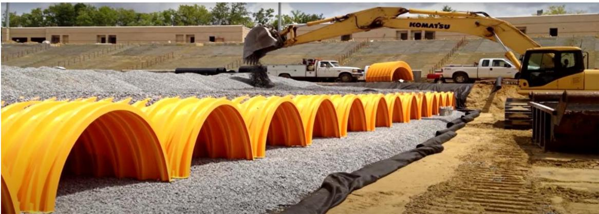
Figura 41.- Instalación de un Sistema ADS StormTech (vista lateral/frontal).
