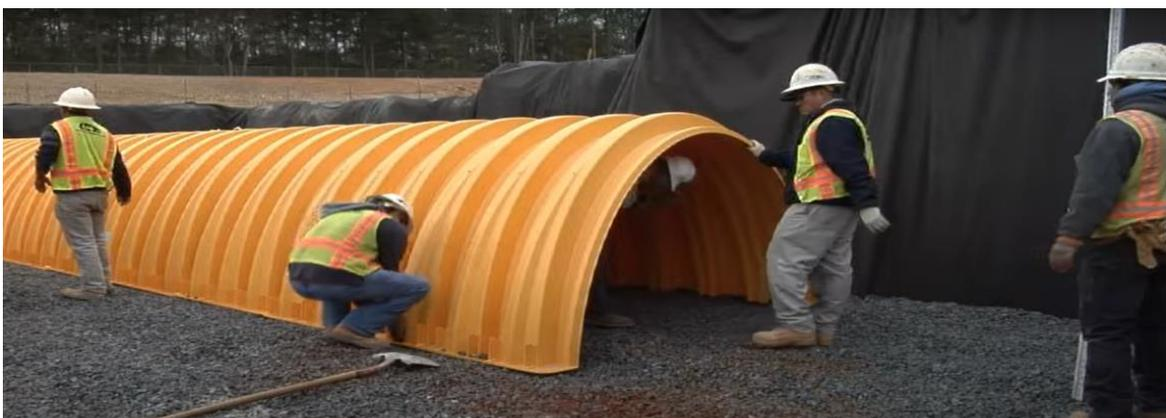
Figura 42.- Instalación de cámaras (acoplamiento).
