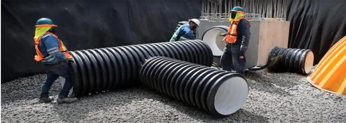
Figura 40.- Manifold y estructura de entrada/ salida.
