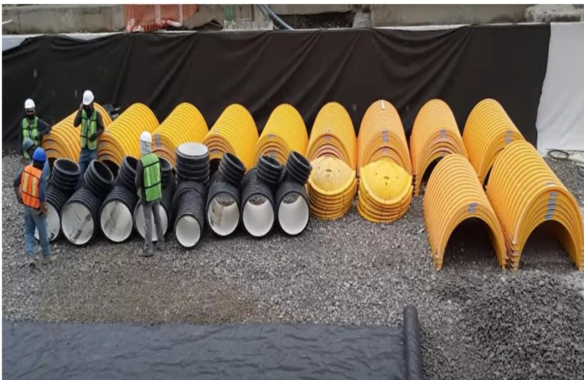
Figura 39.- Componentes de un Sistema de cámaras StormTech.
