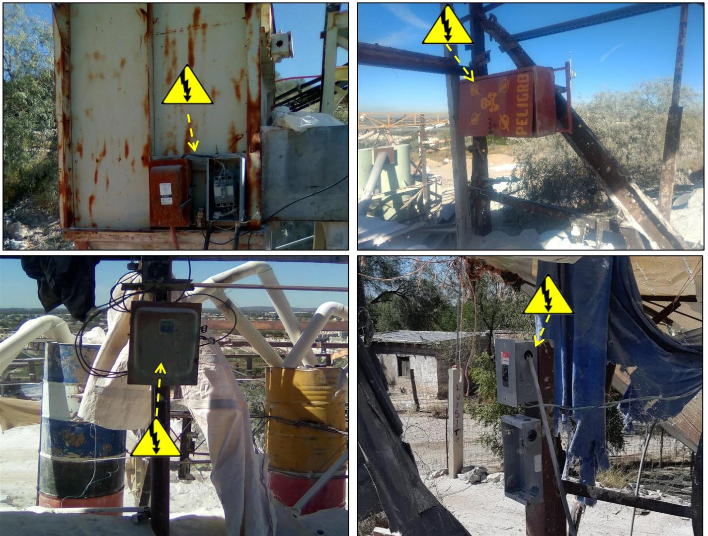
Figura 4.5: Imágenes de análisis de riesgos (RI) y (RE) por el uso de energía eléctrica y las instalaciones utilizadas en el lugar
