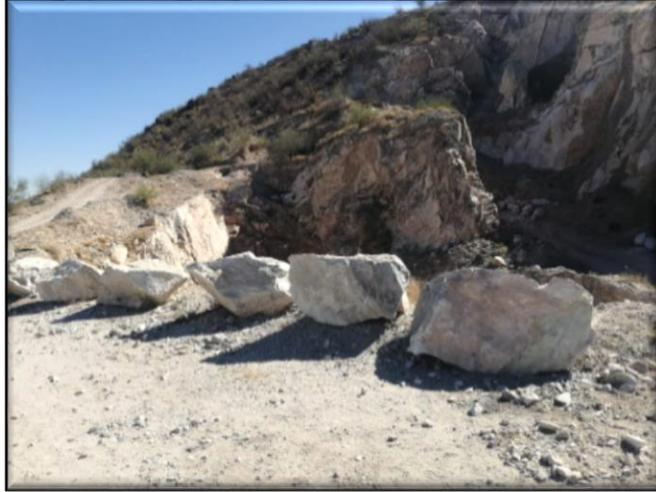
**Figura 3.7: Uso de rocas como muro de contención en áreas de alto riesgo, para evitar algún accidente de personas o vehículos que circulen por el área de trabajo**
