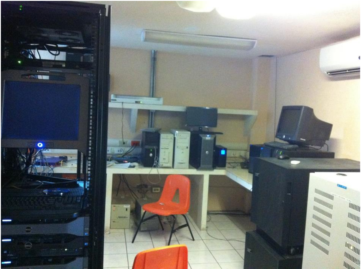
Figura 4.1. Imagen de entrada del área de equipos de cómputo.
