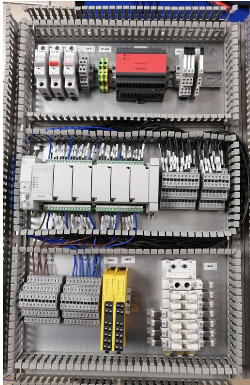
Imagen 8.1.2 Avance de ensamblado de gabinete de control. {1}
