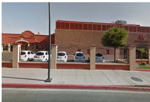
Imagen 1. Fachada principal Arca Continental - Coca Coca Hermosillo
