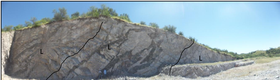
Foto 22. Unidades geotécnicas, de la unidad litológica Morelos Final.
