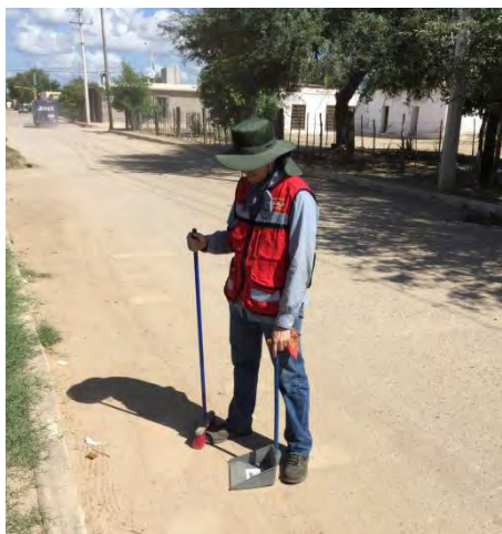
Barrido en calle asfaltada
