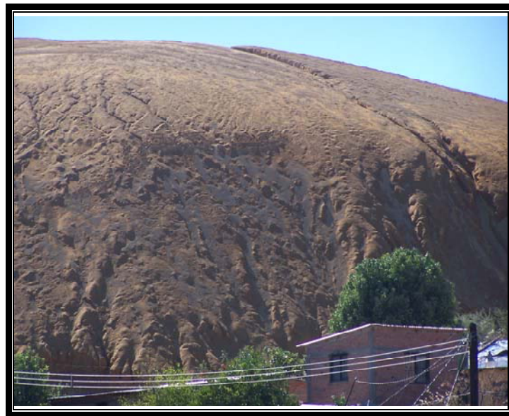
Fotografía 14.- Alta pendiente del bloque de inestabilidad crítica en el noroeste del sitio de los jales.
