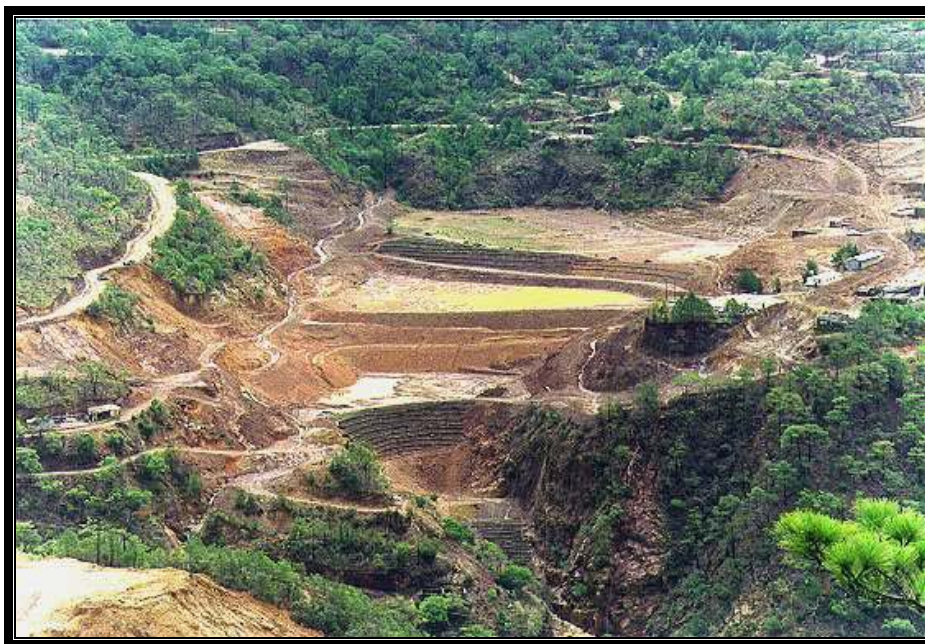
Fotografía 4.- Vista de los trabajos de restauración en la mina Cuale (Huerta, 2005).
