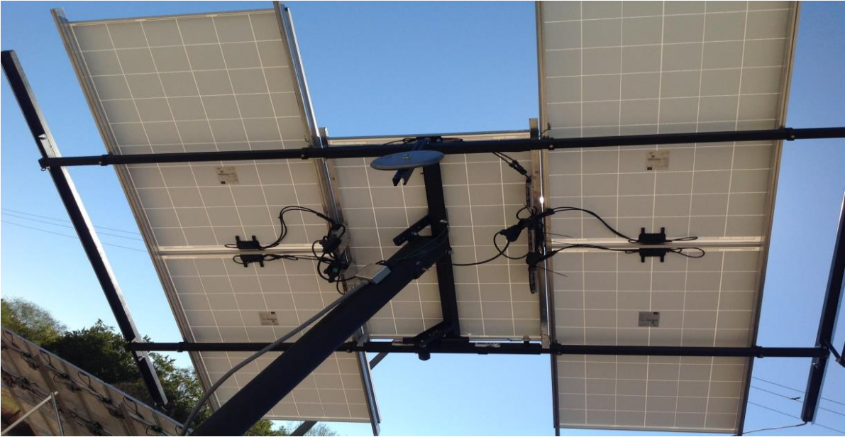
Figura 4.26 Foto Vista inferior de un seguidor con micro inversores (Mazatlán)
