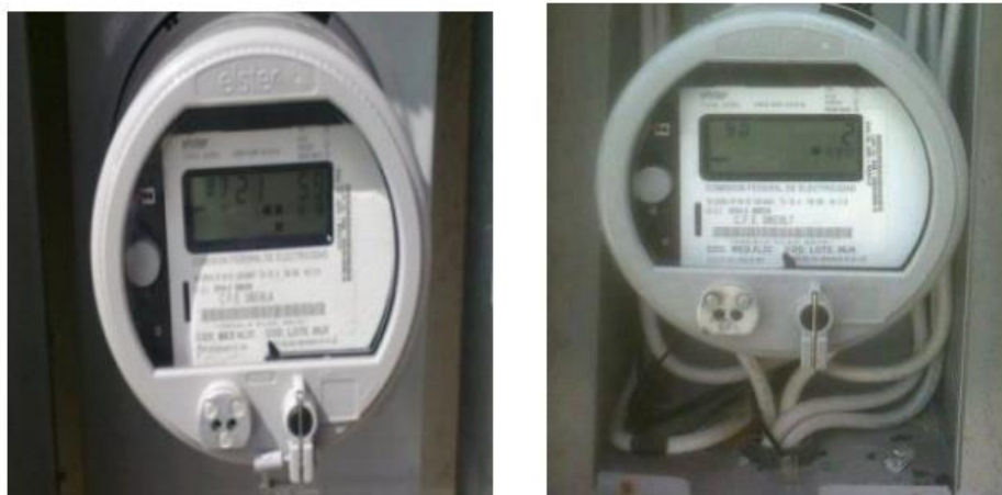
Figura 4.19 Foto del medidor bidireccional de CFE
