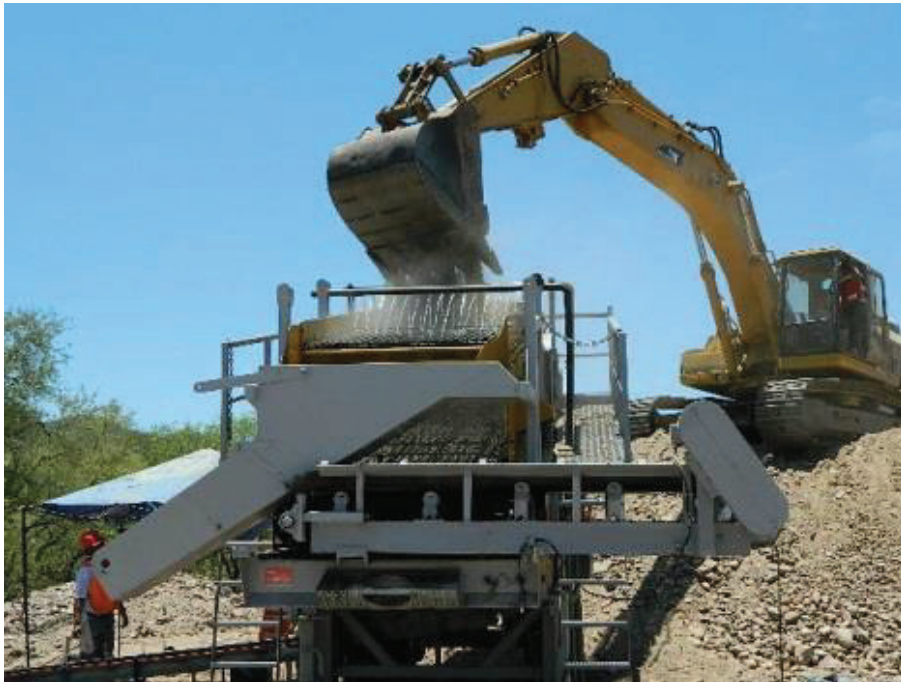
Figura 10. Cribadora vibratoria en operación
