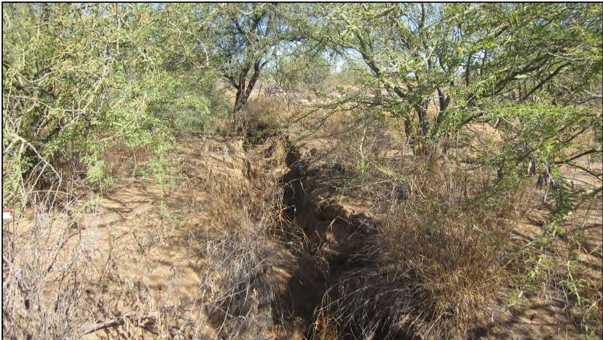
Fotografía 2.- Las grietas que cortan el drenaje natural y la vegetación.
