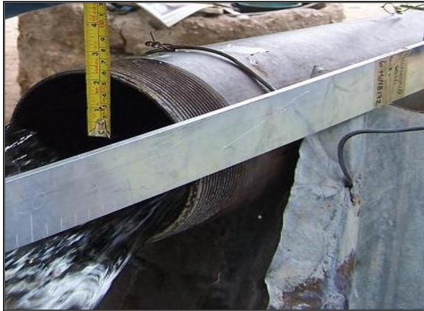
Figura 3.9 Medición de relación X/Y en tubo parcialmente lleno
